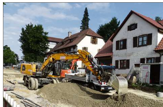
Auch bestimmte Maßnahmen im Rahmen der Sanierung der Dunninger Ortsdurchfahrt werden gefördert. Foto: Schönfelder
